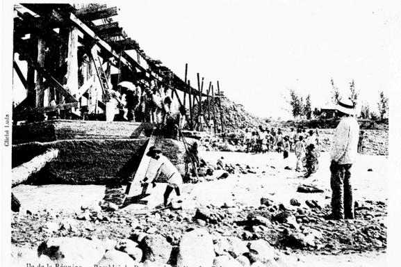
Ile de la Réunion. - Remblai du Pont sur la Rivière des Galets emporté par le Cyclone des 21/22 Mars 1905
